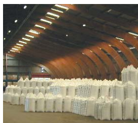
En sécurité : un bâtiment propre, des stocks fractionnés
